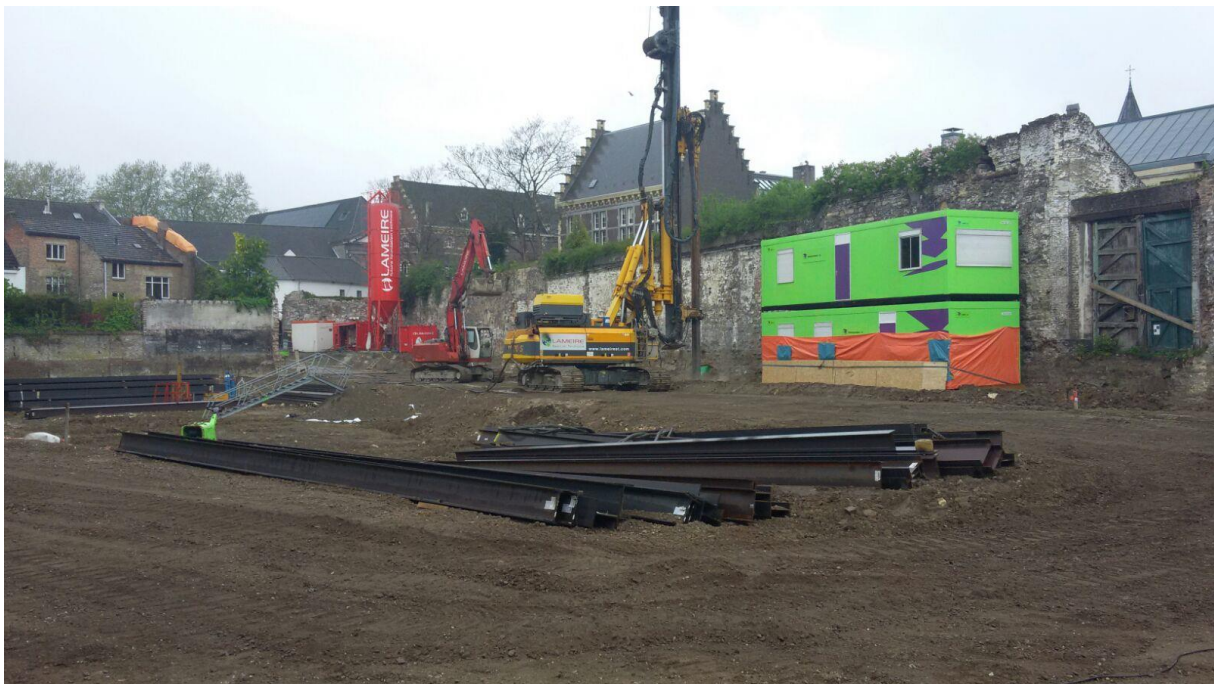
De soilmixwand wordt voorgeboord, gefreesd en geplaatst langs de stadsmuur
