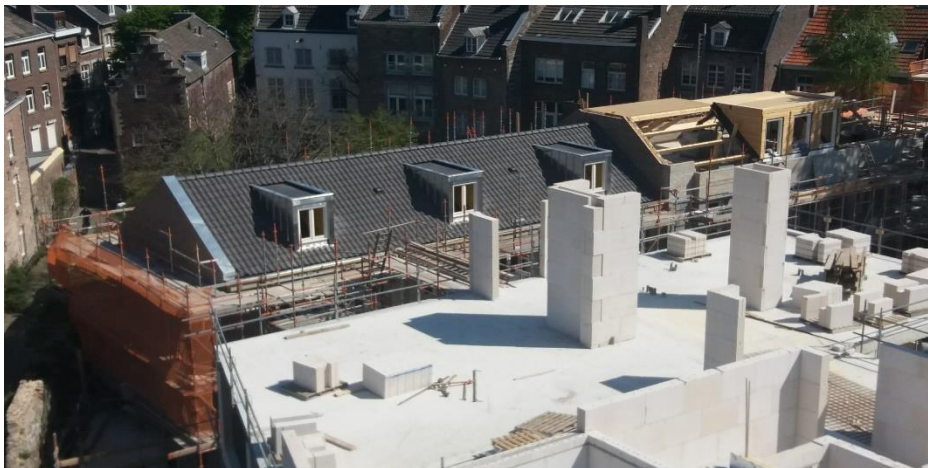
Pannen dak blok C gereed
