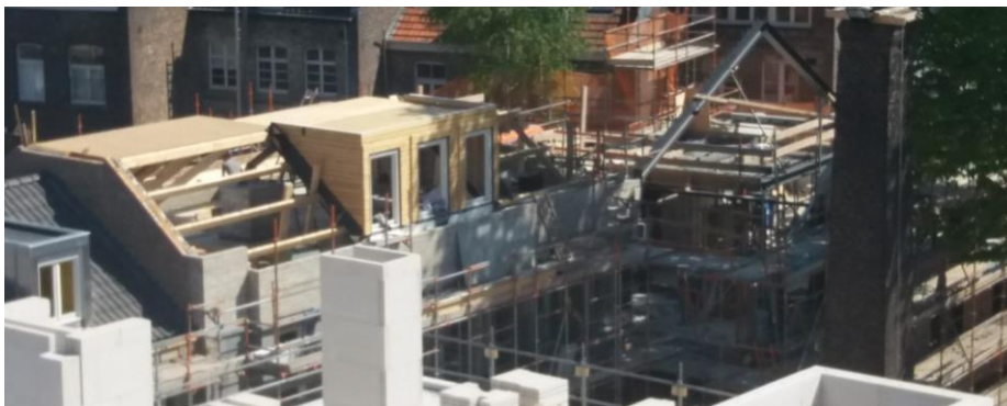
Dakconstructie blok B met rechts staalconstructie blok A
