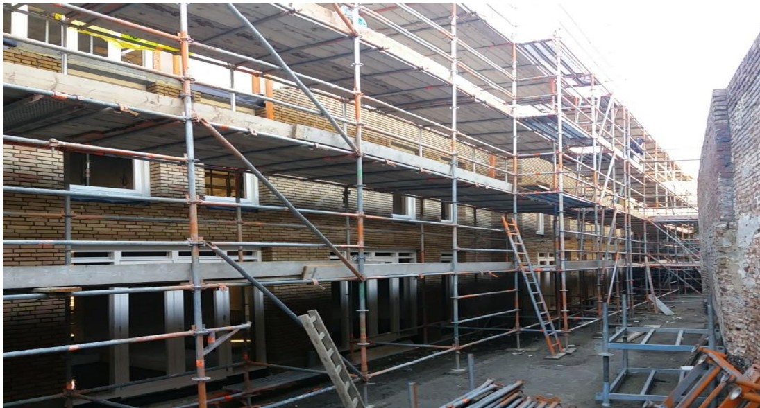
Achtergevel blok B en C
