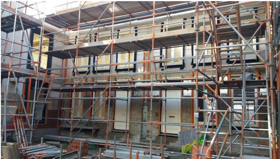
Voorgevels Blok E en links Blok D aanzet metselwerk
