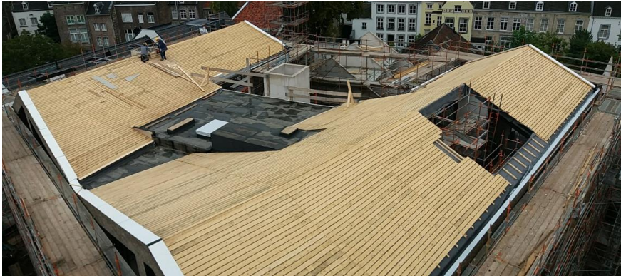
Dak Blok G waarop de houten planken te zien zijn waarop het zinkwerk wordt aangebracht.
