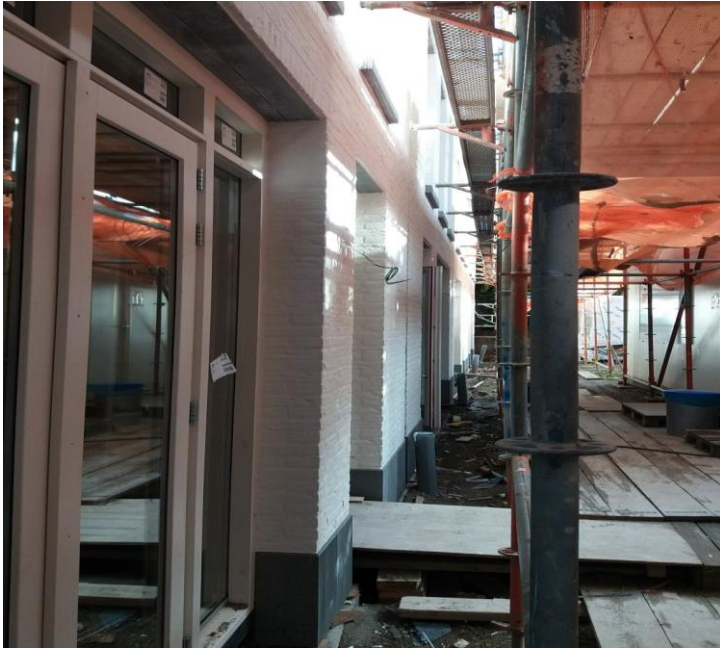
Achtergevel Blok H
